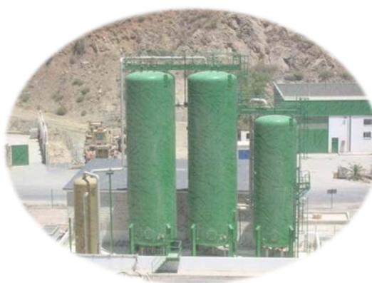
Es importante destacar que LIMASA lleva a cabo la depuración del agua procedente del lavadero de la flota de vehículos para su posterior reutilización en el mismo proceso.
